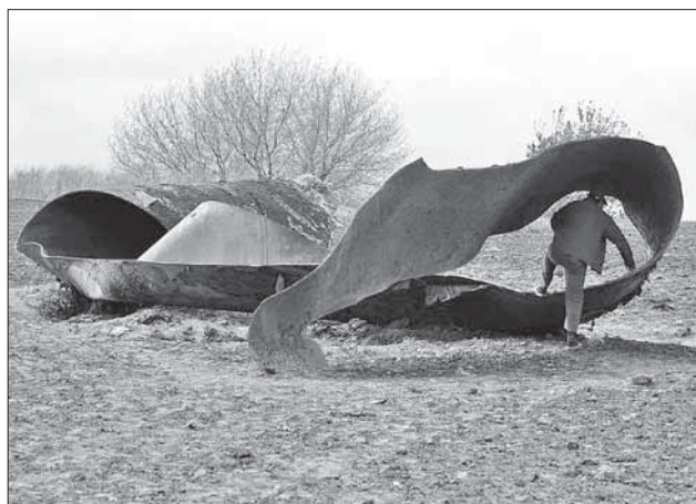
Труба газопровода, искореженная взрывом. Фото УНИАН
