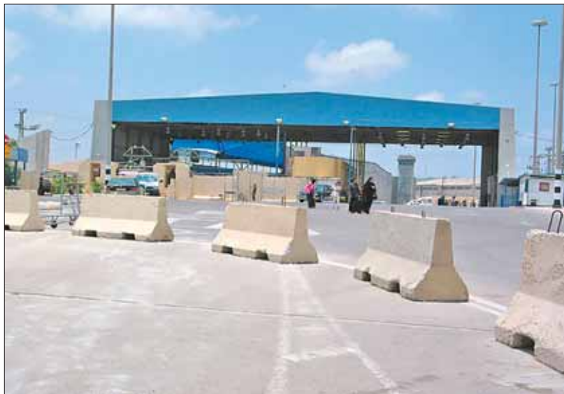
Бетонные блоки, преграждающие подъезды к КПП «Эрез»
