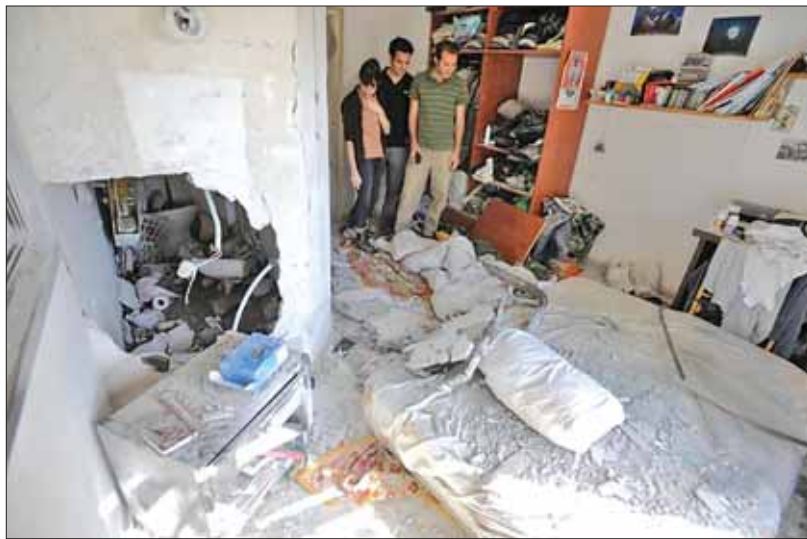
Разрушения, вызванные падением «кассам», выпущенного по Сдероту
