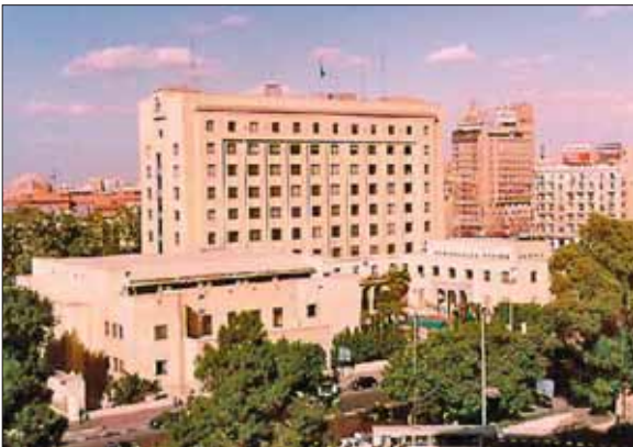
Здание штаб-квартиры ЛАГ в Каире
